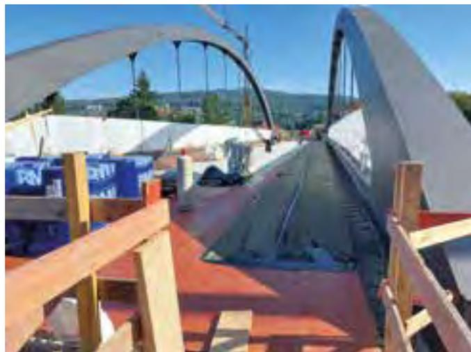
15 Betonage und Aufbringen der Abdichtung
