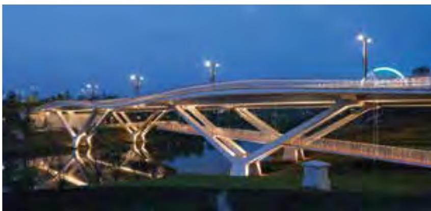
**26 27** Jiangxi-Brücke Chengdu: seitliche und abgehängte Geh- und Radwege
