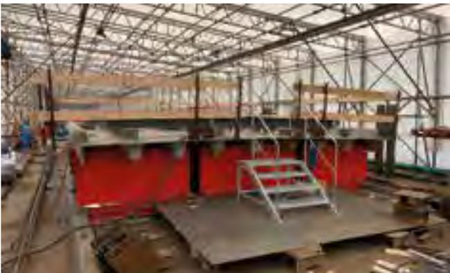
15 Vorzusammenbau dreier Einzelsegmente zu einem Fahrbahnplattenabschnitt
