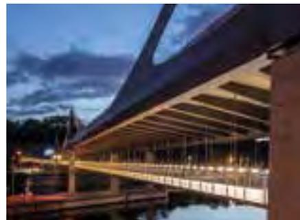
22 23 Neckarbrücke Stuttgart mit abgehängtem Steg
