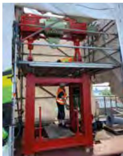
6 Ersatzhänger mit Spannrahmen und freiem Hängerseil
