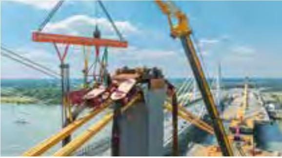
13 14 Befestigung der Hilfsseile am Pylonhut
