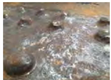
9 Substanzverluste an der Tragstruktur im Gleisbereich © SEH Engineering GmbH
