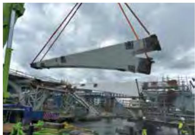
14 Einhub eines Hosenstücks: Segment 5, Hauptträger 2 © Porr Bau GmbH
