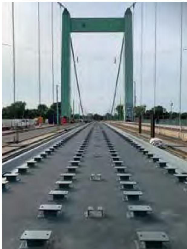
20 Fertiggestellter und mit Belag versehener Gleisbereich nach Fahrbahn-tausch © SEH Engineering GmbH
