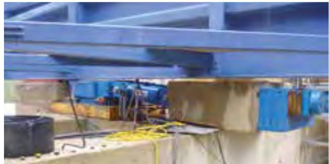
14 Ausführung der Hub-Schub-Anlage auf dem Taktschiebewiderlager
