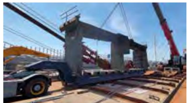
11 12 Rückbau der Hohlkästen und Abtransport eines Elements
