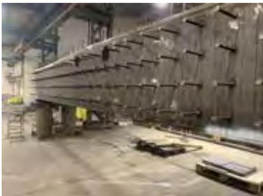
8 Herstellung der Stahlstabbogenbrücke im Werk
