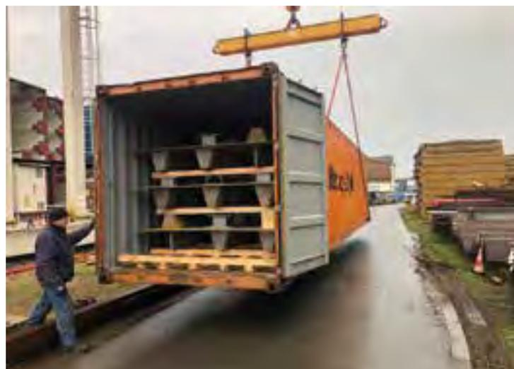
12 Verladung der vorgefertigten Fahrbahnsegmente in Hannover
