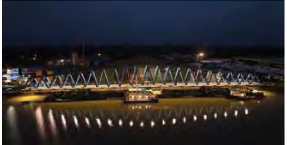
10 Transport der Drehbrücke mit zwei Pontons
