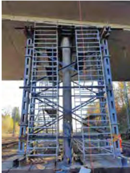
3 Notgerüst zur Sicherung in Pfeilerachse 2
