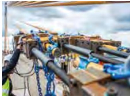
17 18 Kabelspannungssystem und Kabelklemm-Konstruktion als Neuentwicklungen
