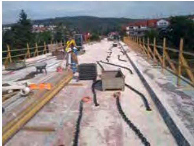
4 Seilsägen und Ausheben der Teile
