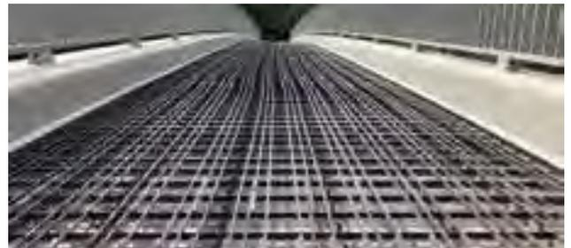
29 Geh- und Radwegbrücke Bauwerk 396b: Bewehrung aus Basaltfasern
