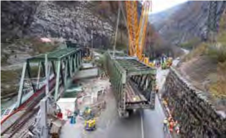
9 Salzachbrücke Pass Lueg: Aus- und Einhub mittels Schwerlastkran
