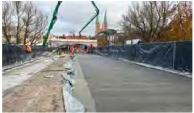
10 Betonage der Orthoverbundplatte
