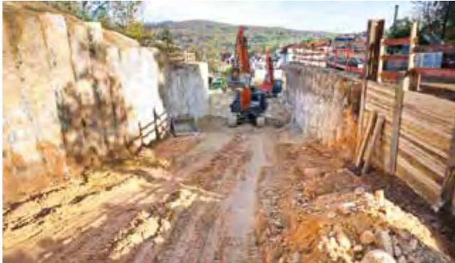
7 Herstellung der Baugrube in Achse 10
