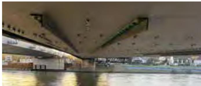
7 8 Holo-Bolt-Verbindungen am Bodenblech
