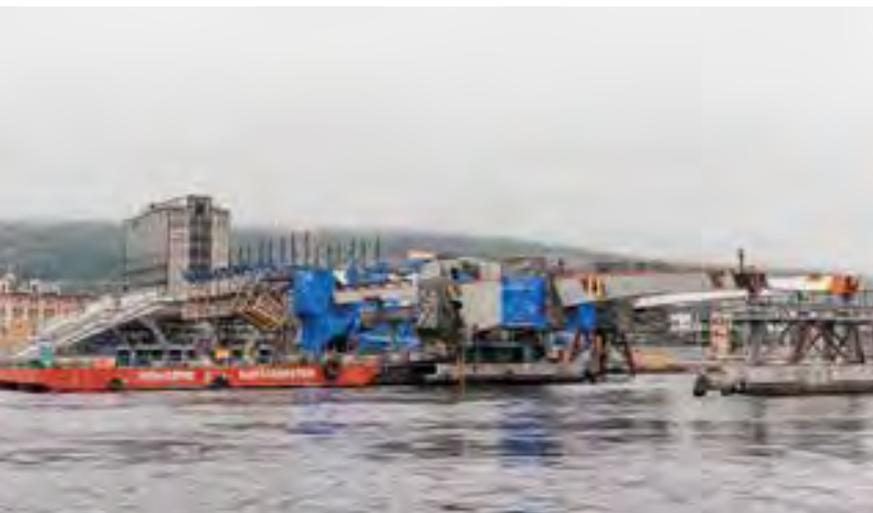
16 Strømsø-Brückenhälfte mit Montagehilfskonstruktionen, Hängegerüsten und Schalwagen © Viktoria Grötzl
