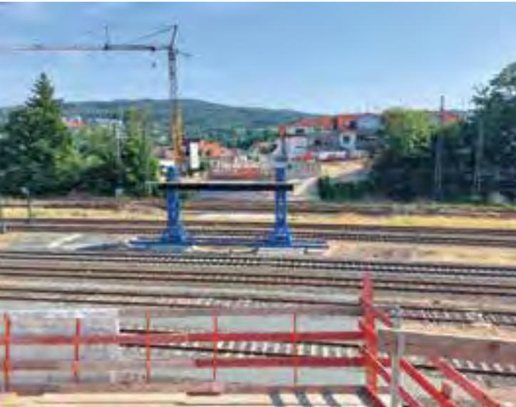
13 Errichtung einer temporären Mittelstütze
