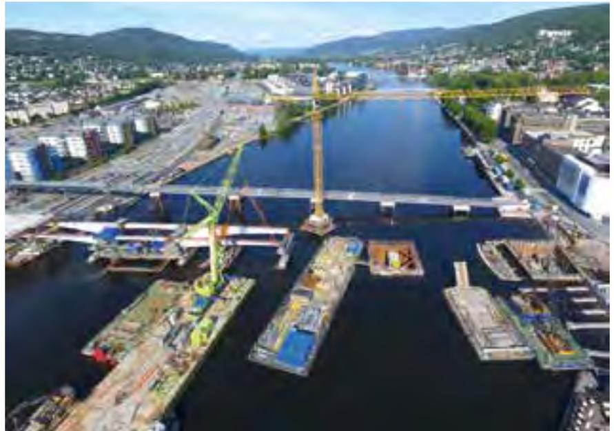
15 Einhub von Segment 8, Hauptträger 2 und wasserseitige Arbeiten am Pfeiler in Achse 8 © PNC Norge AS
