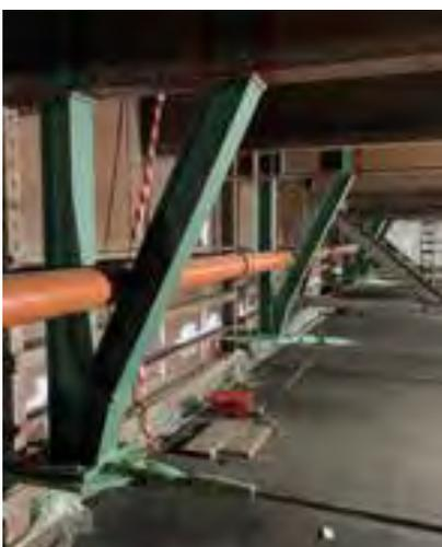
5 Geschraubte Rahmeneckverstärkung mit Zugspannglied
