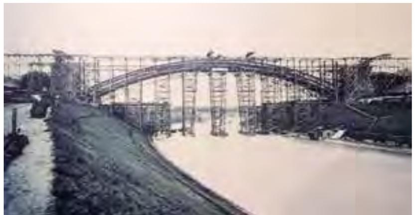
6 Herstellung der ersten Hochbrücke Levensau auf einem Lehrgerüst aus Holz
